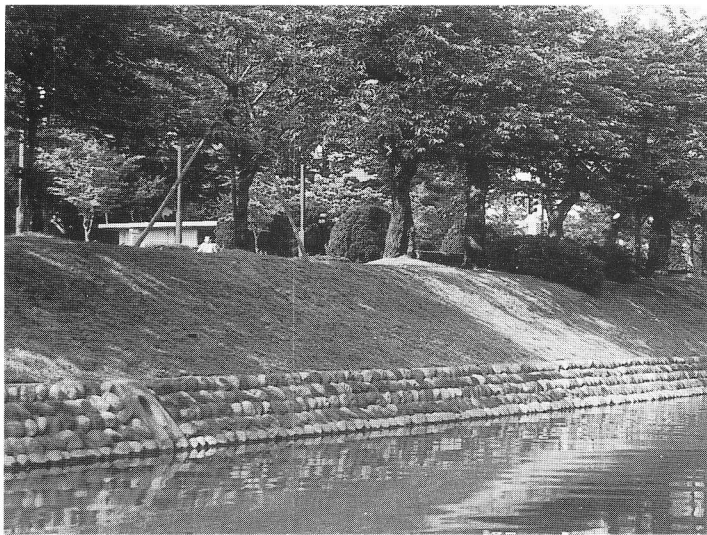
▲均一の玉石が整然と並ぶ松川の護岸には、自然の潤いが感じられない。
