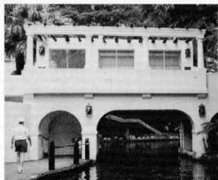
●増水した水を川の中の街へ入れないため設けられた水門。
